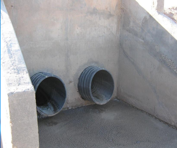
Figura 6.- Compuertas de salida, limpias y sin residuos de tierra u organismos.
