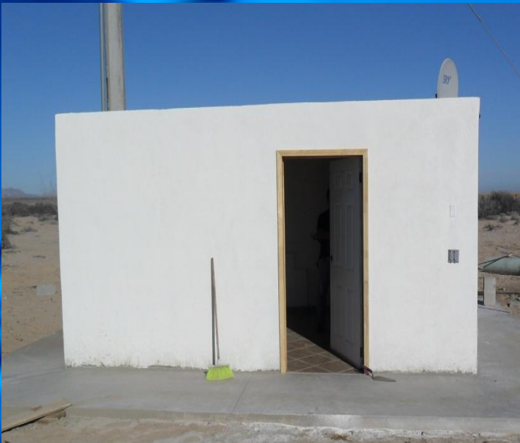
Figura 3.- Almacén para guardar materiales de siembra y cosecha. Este almacén se ha construido de acuerdo a las recomendaciones del Manual de BPPAC.
