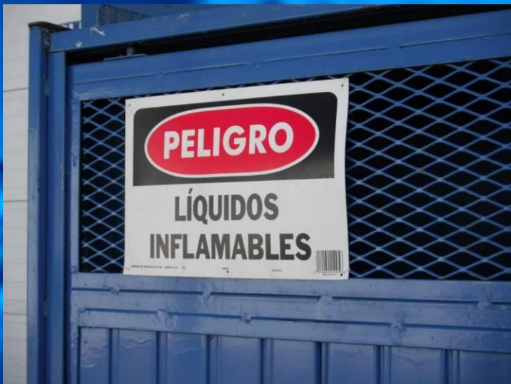
Figura 20. Sustancias químicas almacenadas en un área de acceso controlado y separadas de cualquier otro insumo utilizado en la planta de procesamiento primario.
