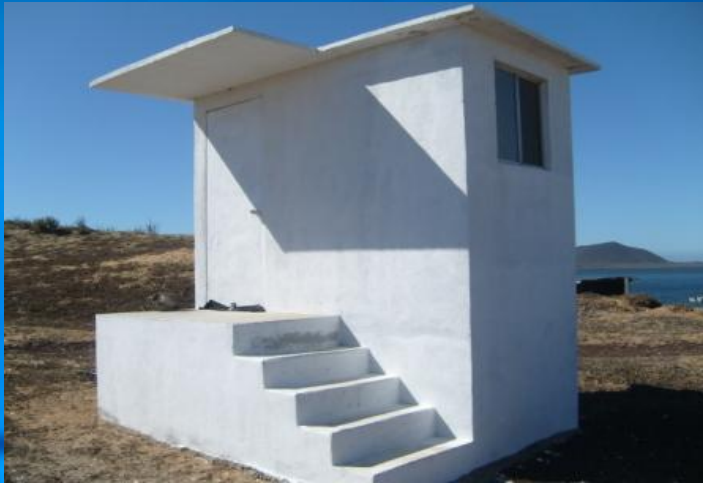
Figura 5. Mantener las Instalaciones sanitarias bien cuidadas y limpias, así como el uso adecuado de las mismas es indispensable.
