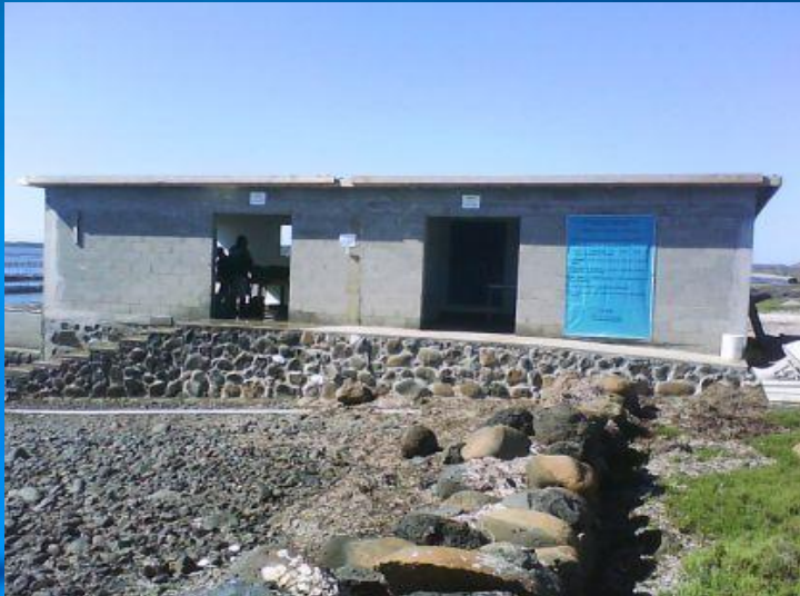
Figura 3. Instalaciones acuícolas limpias y adecuadas de acuerdo al proceso de producción.
