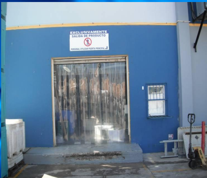
Figura 22. Puerta exterior de planta de procesamiento primario, con cortinas de plástico en buen estado, las cuales impiden la entrada de insectos y polvo.
