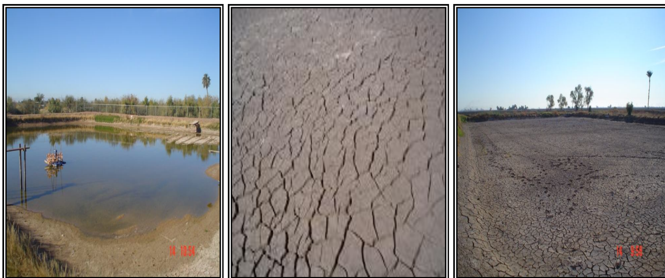
Fig. 34. Izquierda. Estanque que no drenó completamente, por lo que hay que eliminar las charcas con ayuda de motobombas. Centro y derecha. Suelo agrietado en proceso de desecación total
