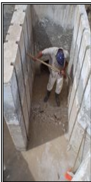
Fig. 3. Limpieza de compuertas
