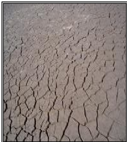
Fig. 2. Fondo de estanque en proceso de secado sanitario.
