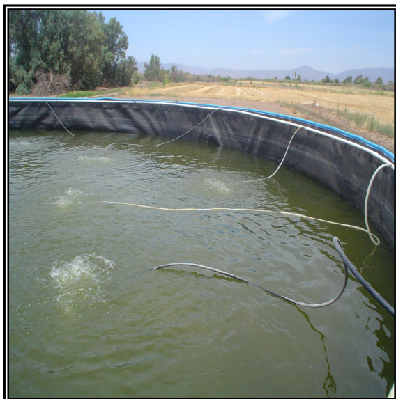
Fig. 18 Estanque de aclimatación, el tamaño dependerá de las características de cada unidad de producción.
