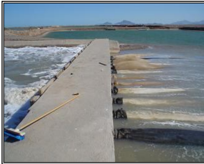
Fig. 8. Filtros de bombeo de 300 y 500 micras previamente desinfectados.
