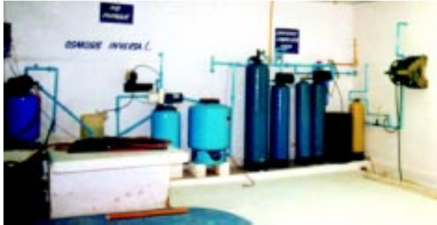
Figura 5.1 Sistema de ósmosis inversa utilizado para obtener agua potable para el procesamiento de productos acuícolas.
